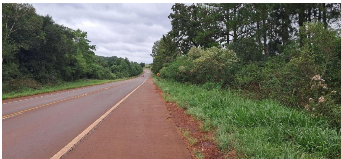
Imagen 20. P.K: 41+450: Inicio de tercera trocha (Descendente). Nota: Predominan en la zona baja, flores de Verbena y Glandularia junto a arbustos de Chilca y Fumo Bravo ( Solanum ). Al fondo a la derecha se ven copas más altas de Pinos y algunos Paraísos que no se consideran susceptibles de ser afectados. Fotografía tomada el 18 de marzo de 2026.
