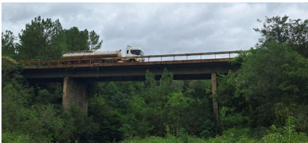
Imagen 26. Puente sobre Arroyo Yazá en intersección de la traza vial. Fotografía realizada el 17 de Marzo de 2026.
